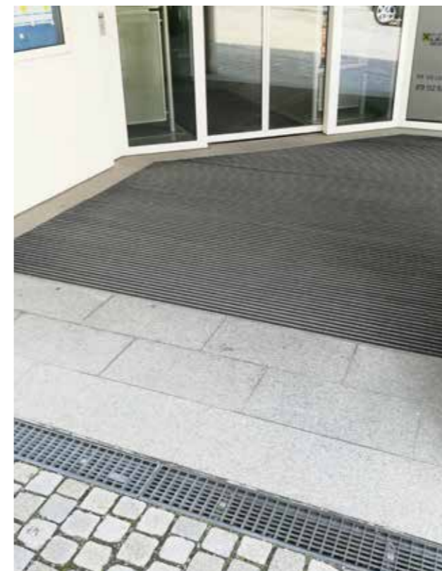
Türschwellen beseitigen; Türen mit Öffnungsautomatik
