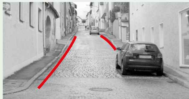
Die Gehringstraße: Eine marode Straßenschneise durch die Innenstadt.
