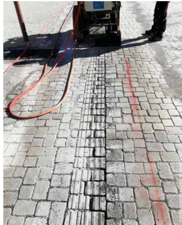
Mechanische und technische Leitsysteme installieren, z.B. durch Fräsung
